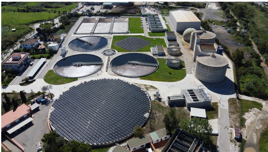
Estación depuradora de EsteponaLa Razón
